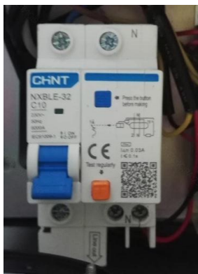
图3-2 电源空开实物图
